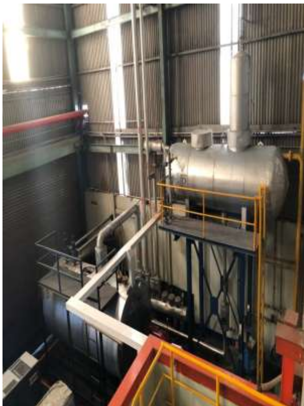
HTXLKT lò hơi 1 công suất 5.000 m 3 / giờ
