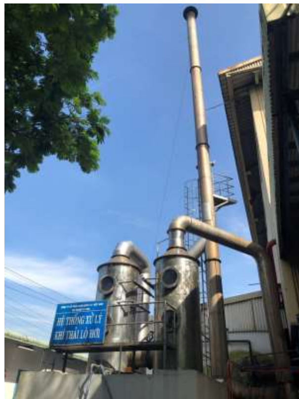
HTXLKT lò hơi 1 công suất 5.000 m 3 / giờ
